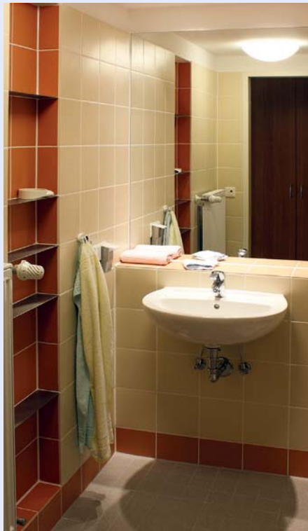
Niedrige Vorwandinstallationselemente bieten Einsehbarkeit des Spiegels aus sitzender und stehender Position. Dieses Bild zeigt eine Wohnanlage in Berlin.
