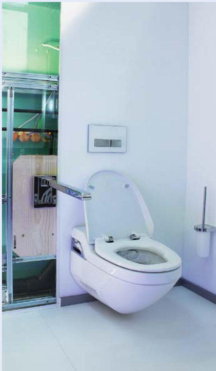
Nicht nur die Nachrüstung von Stützgriffen, sondern auch die spätere Ausstattung mit einem Dusch-WC (hier AquaClean, Geberit) steht für Anpassbarkeit.
