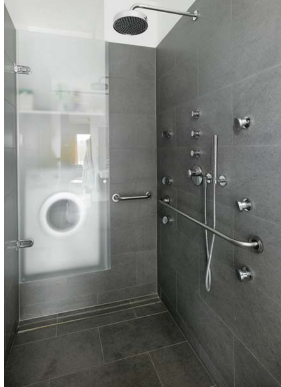
Barrierefreie, niveaugleiche Duschanlage mit intelligent gelöster, spritzwassergeschützter Waschmaschinenaufstellung hinter Glas.
